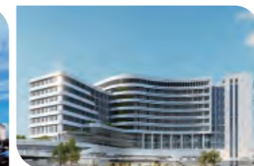
本校附設岡山醫院 KMU Gangshan Hospital
